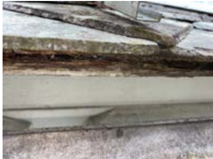
Råteskade for tretro
