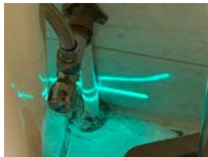
Rørgjennomføring i gulv.
