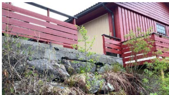
Åpning i rekkverk må lukkes, pga fare for fall.
