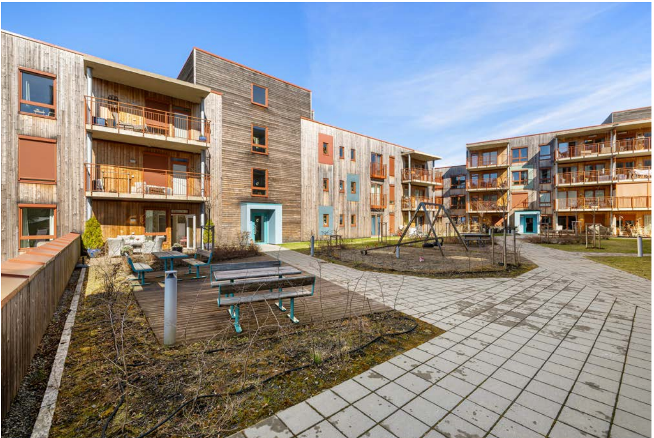
Sameiet har et pent opparbeidet og innbydende atrium som fungerer som et hyggelig felles møtepunkt for beboerne.
