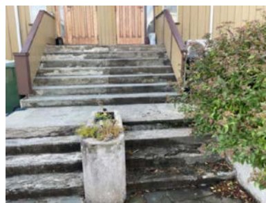
Felles inngangstrapp i plasstøpt betong mot kommunal vei.
