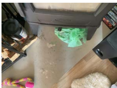
Ikke tilfredsstillende avstand til brennbart materiale i front.
