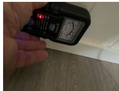
Fuktkontroll på vegg viste ingen unaturlige verdier ved bruk av fuktindikator.
