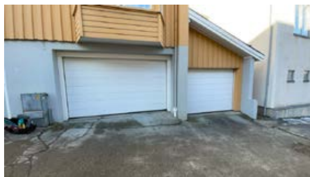
Garasjeport (til høyre
