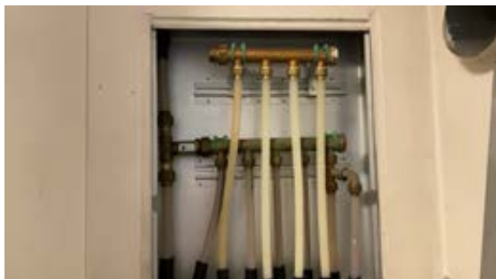
Rørkurser på rør-i-rør system bør merkes.
