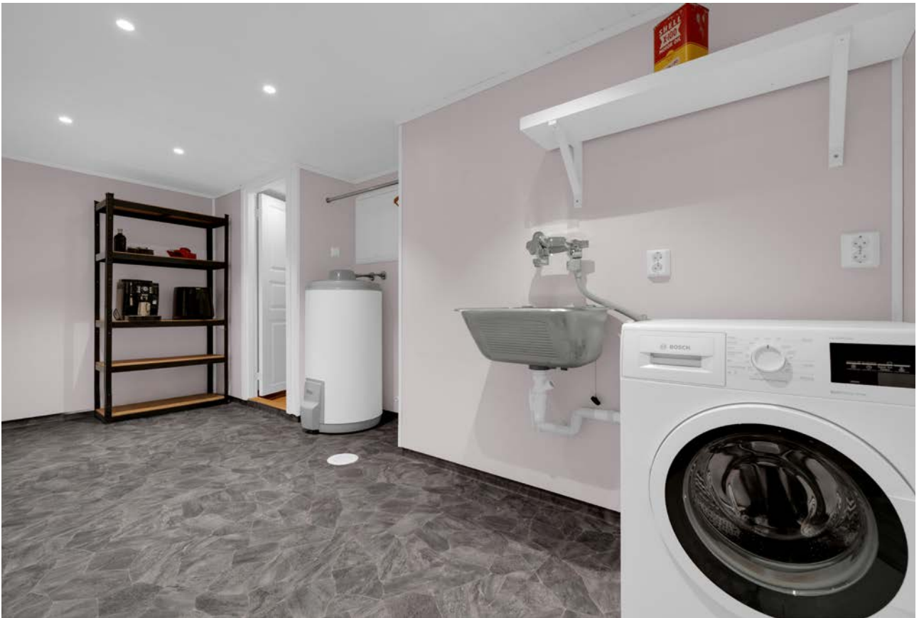
Vaskerommet ble oppgradert i 2024, med vinylbelegg på gulv og malte veggplater, og inkluderer opplegg for vaskemaskin og en ny varmtvannsbereider.
