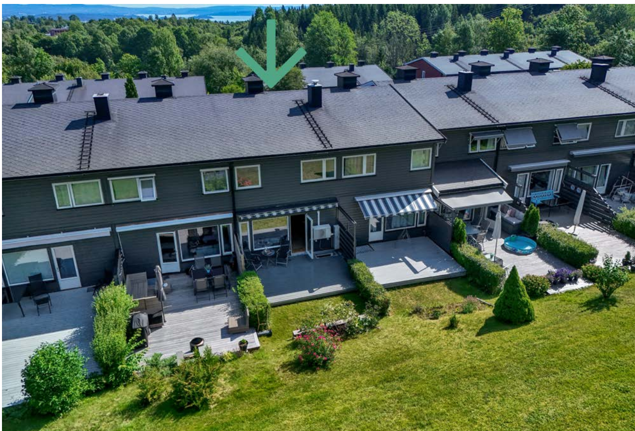
Hagen er pent opparbeidet og grenser til et større grøntområde.
