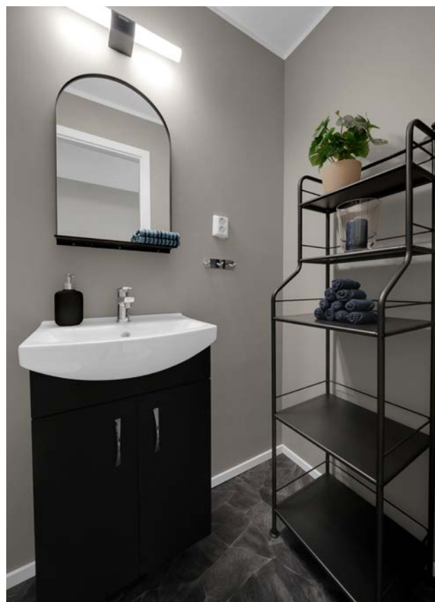
Toalettrommet har vinylbelegg på gulvet og malte plater på veggene.
