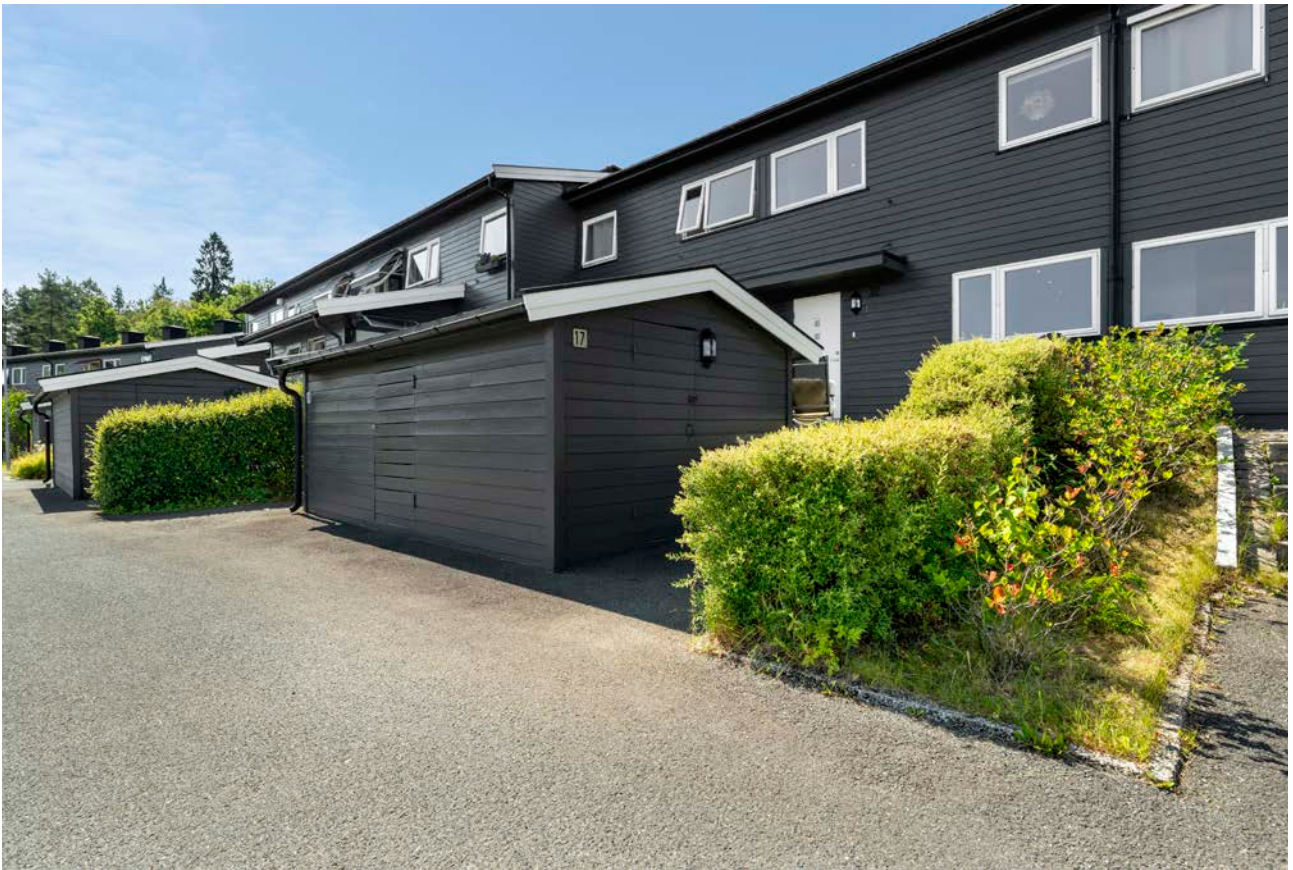
Boligen har en utvendig bod tilknyttet seksjonen.
