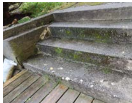
Støpt trapp nord.
