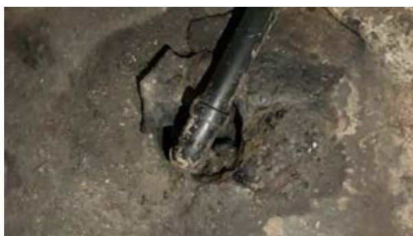
"Sluk" i gulvet.
