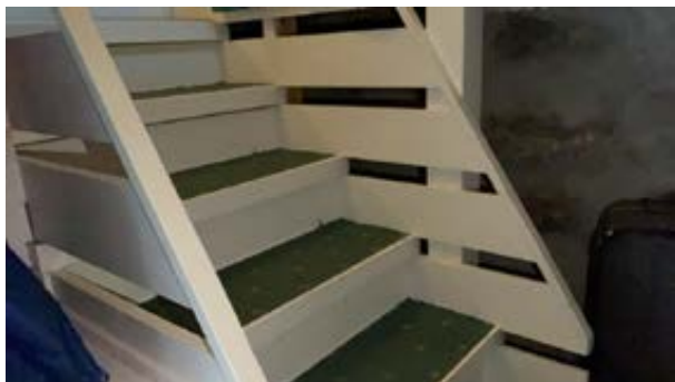
Tretrapp fra kjeller til 1.etasje.
