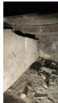
Sprekk i ildfast stein på vedovn kjellerstue.
