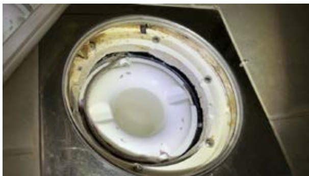
Sluk i dusjsonen
