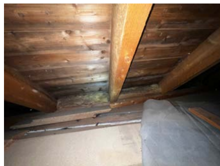
Sperrerom er fullisolert stedvis.
