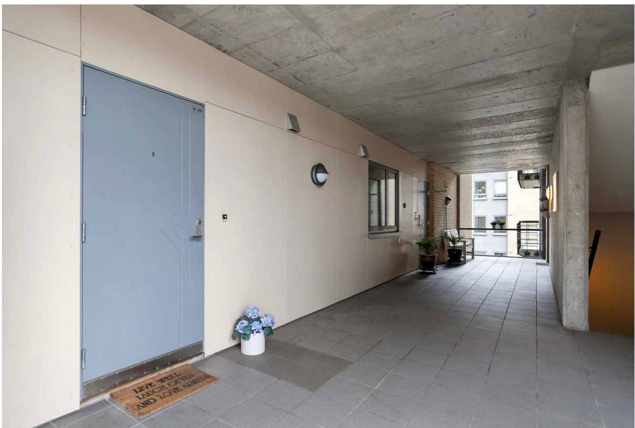
Ytterdør i svalgang, med trapp og heis rett utenfor
