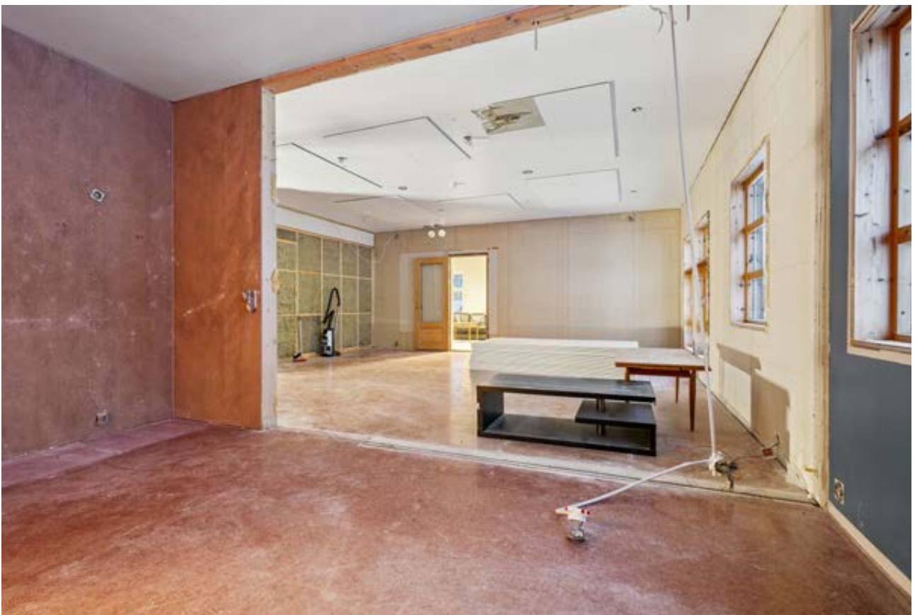
Under renovering/ombygging til fritidsleilighet
