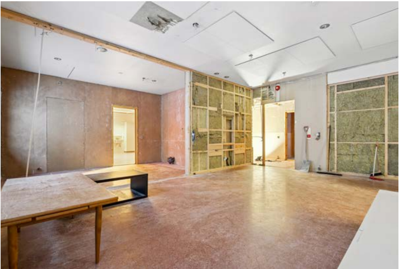
Under ombygging til fritidsleilighet
