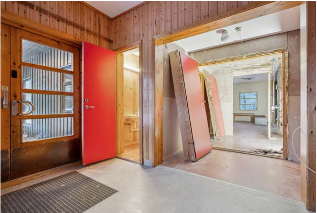
Inngangsparti- under ombygging/renovering til fritidsleilighet
