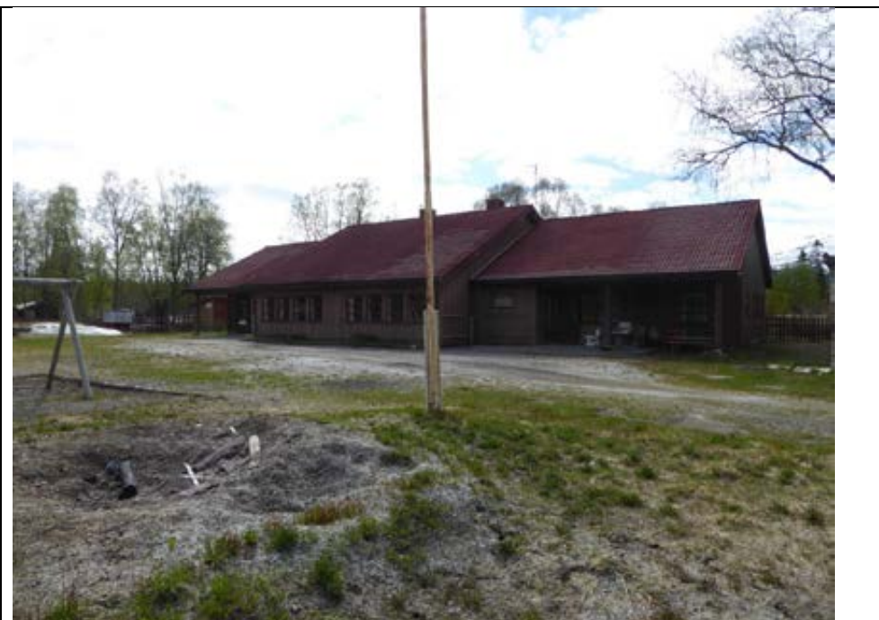
Bilde over viser eksisterende Kosmo skole (2020)
