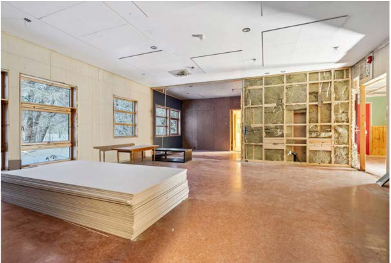
Under ombygging til fritidsleilighet
