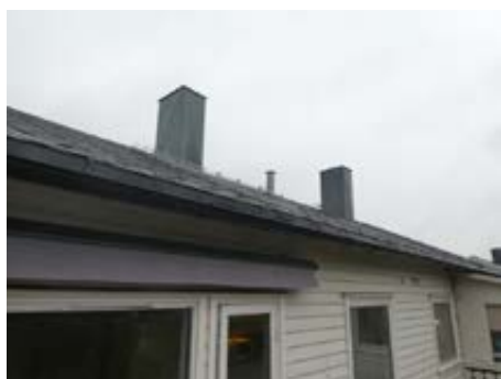
Markiser ved terrasse
