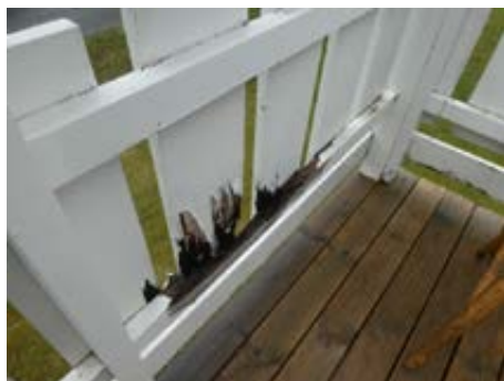
Råteskade på deler av rekkverk
