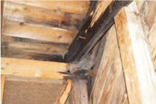
Eldre fuktmerker i bordtro. Det er påvist fuktskjolder i undertak/takkonstruksjon.
