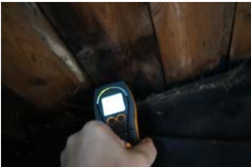
Eldre fuktmerker i bordtro. Det er påvist fuktskjolder i undertak/takkonstruksjon.
