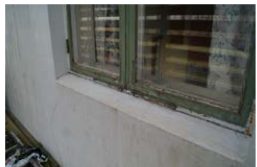
Noen kobla vindu av eldre dat
