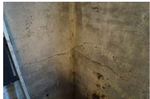
Det er observert enkelte sprekker i grunnmuren, blant annet gjennomgående sprekker ved hushjørne / vaskerom.
