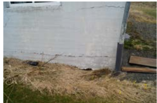
Det er observert enkelte sprekker i grunnmuren, blant annet gjennomgående sprekker ved hushjørne / vaskerom.
