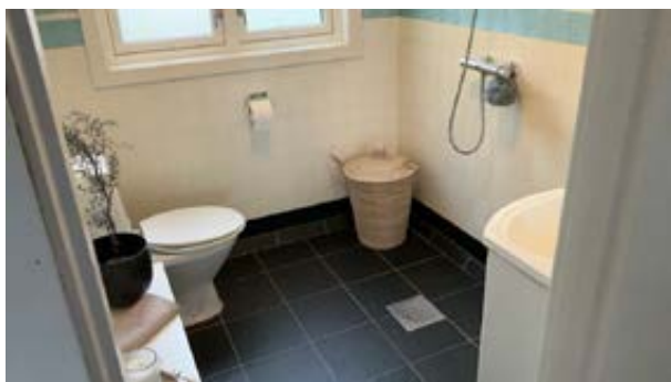
Oversikt bad 1.etasje
